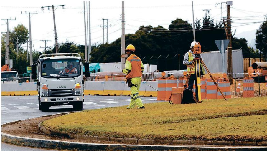
LAS OBRAS DE LA ROTONDA DE CONCÓN PARTIERON EN 2018 Y AL AÑO SIGUIENTE ESTUVIERON DETENIDAS DEBIDO A UN HALLAZGO ARQUEOLÓGICO.
